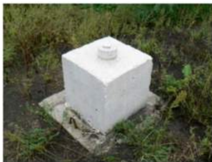
Slika 10.19. Tipski geodetski reper
