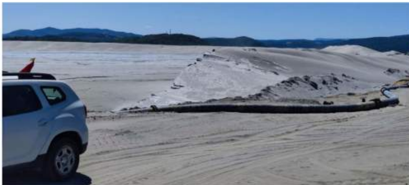
Slika 10.12. - Dejstvo erozije vode i vetra na spoljašnju kosinu nasipa br. 6 u pravcu PS Kaluđerica, avgust 2021. godine
