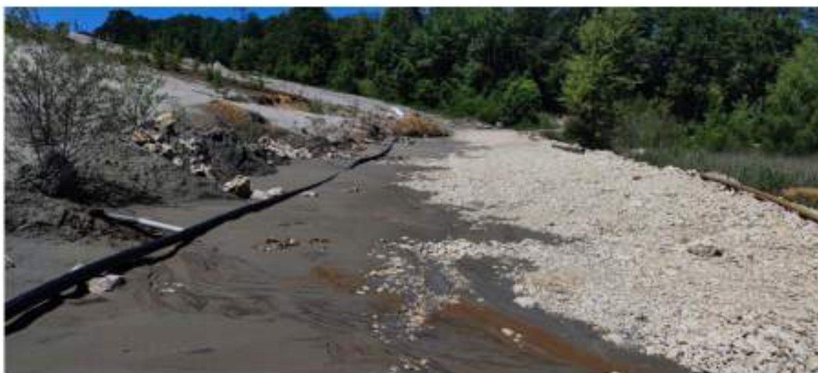
Slika 8.18. – Novoizgrađeni drenažni sistem brane "Prevoj Šaška" spojen sa plastičnim odvodom, maj 2022. godine
