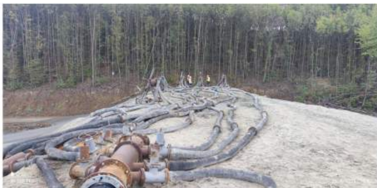
Slika 8.15. – Nastavak izgradnje brane 4 ka prirodnom terenu i mestu spajanja sa njim, avgust 2022. g.
