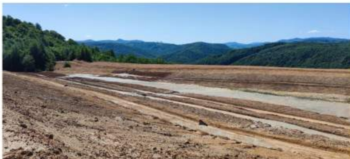
Slika 8.7. – Priprema spoljašnje kosine brane Kaluderica za tehničku i biološku rekultivaciju, maj 2022. godine
