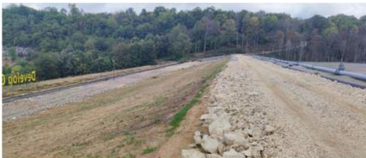
Slika 8.5 – Izvršena rekultivacija i nasipanje šljunkom krune Brane 1, snimljeno avgusta 2022. godine
