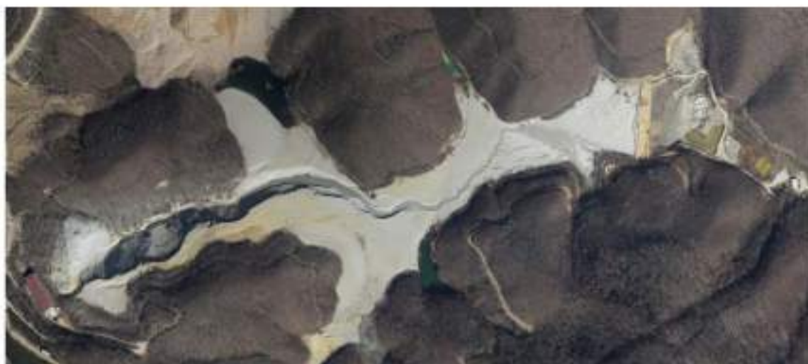
Slika 8.28. – Ortofoto snimak jalovišta "Šaški Potok", geodetska služba RBM-a, mart 2022. godine
