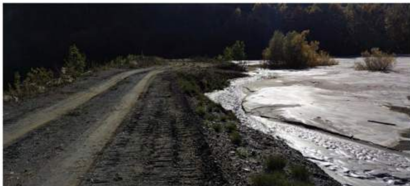
Slika 10.15. – Kruna brane akcidentnog jalovišta "Šaški Potok" snimljena tokom obilaska aprila 2021.
