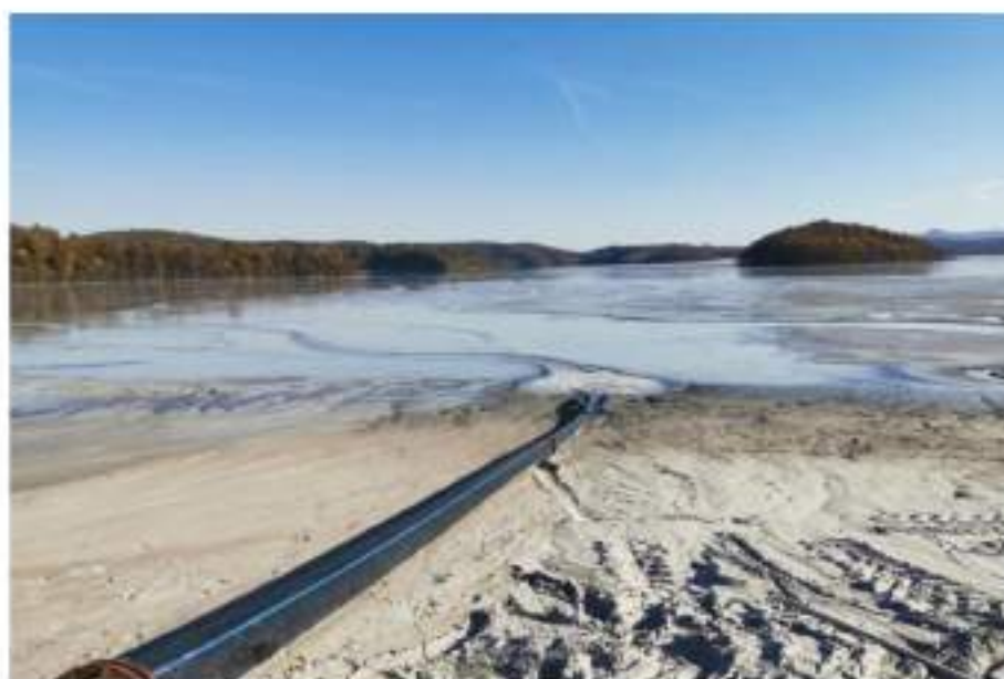
Slika 7.17: Odlaganje mulja i formiranje plaže hc sa Slike 3.7, snimljeno 18.10.2019. god.
