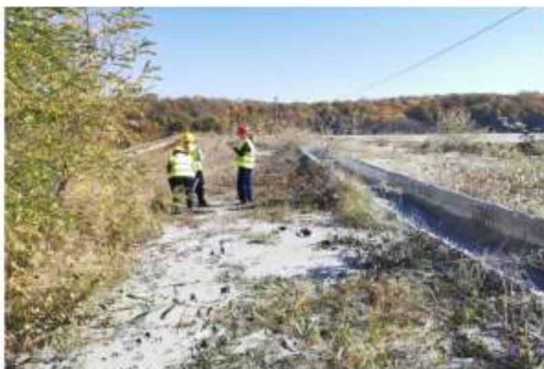
Slika 7.14.: Betonski kanal za gravitacijski transport jalovine od PS 2 do PS "KaludERICA"
