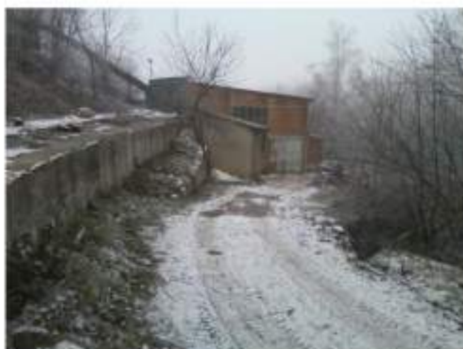
Slika 8.21: Pumpna stanica PS 2
