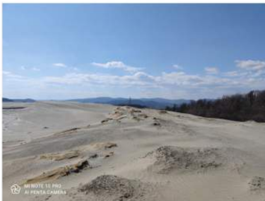
Slika 10.11. - Dejstvo erozije vode i vetra na spoljašnju kosinu nasipa br. 6 u pravcu PS Kaluđerica, maj 2021. godine
