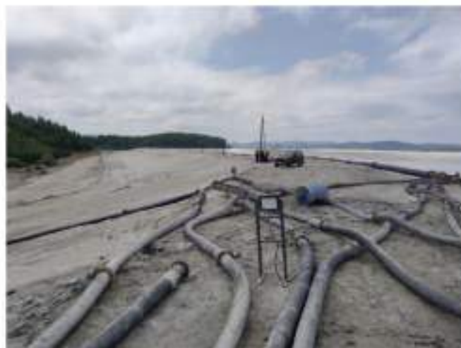
Slika 8.6. – Stepen izgrađenosti brane "Kaluderica", spojena sa "Čoka mika" i "Čoka mare" snimljena na kruni brane na koti K+541 mnv, maj 2021. godine
