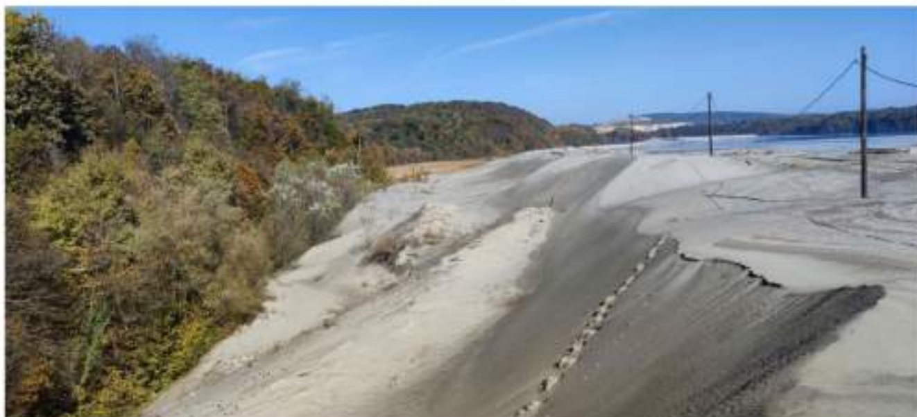
Slika 10.13. - Dejstvo erozije vetra na spoljašnju kosinu nasipa br. 6 u pravcu u blizini vrtača, oktobar 2021. godine
