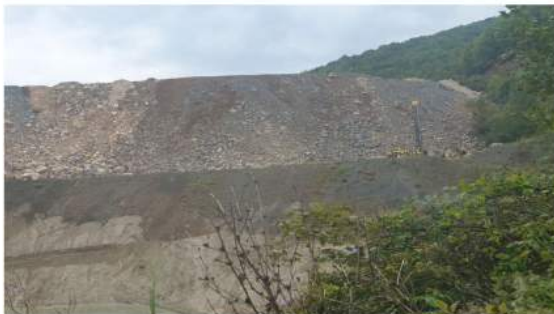
Slika 9.44. – Početak dodatnih geotehničkih istražnih radova na zemljanoj brani akcidentnog jalovišta "Šaški Potok", snimljeno 26.09.2022. godine
