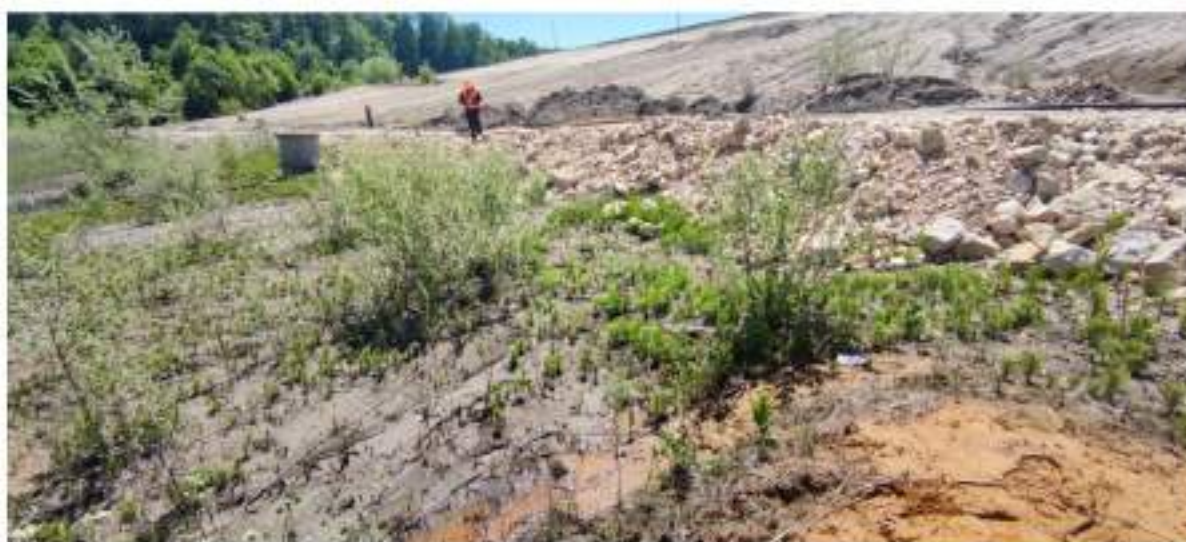
Slika 8.19. – Front procedivanja posle ugradnje nove drenaže, maj 2022. g.
