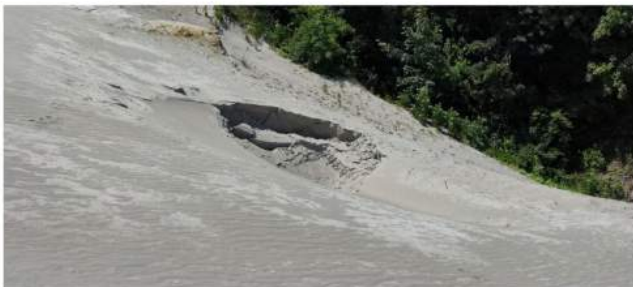
Slika 10.9. - Krateri snimljeni tokom obilaska jalovišta avgusta 2021. godine, jalovište "Valja Fundata"
