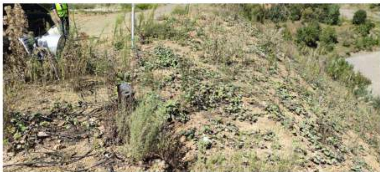
Slika 10.17. – Deo krune brane u desnom boku ugrožen klizanjem materijala usled neadekvatne ugradnje, snimljeno tokom obilaska avgusta 2021.god.
