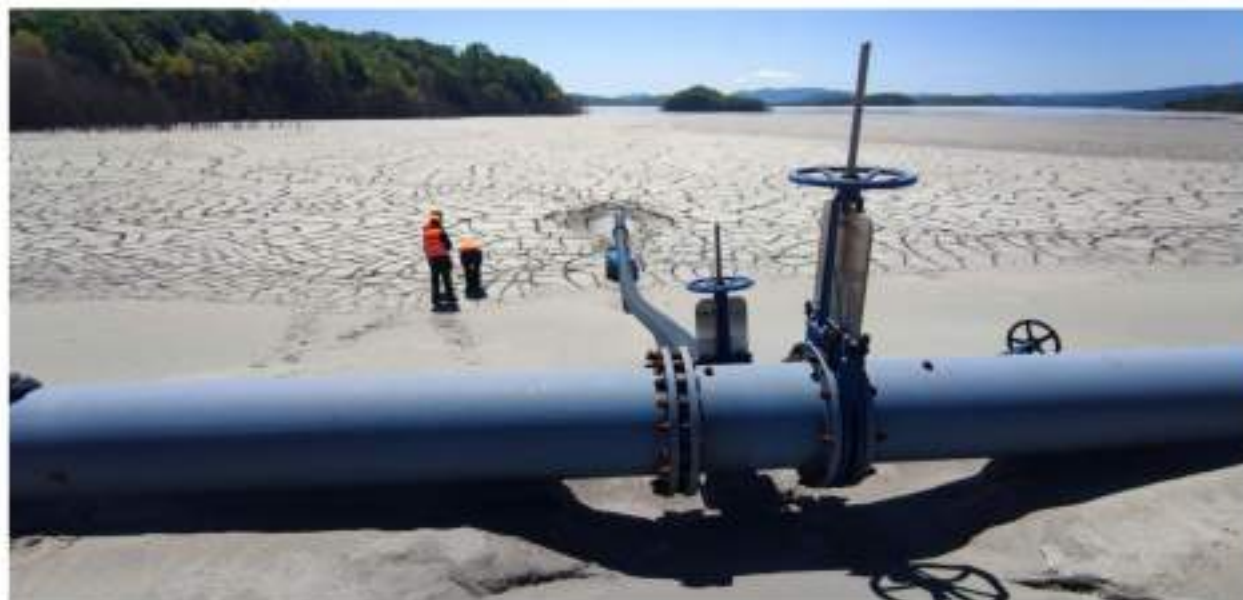
Slika 8.4. – Novi sistem za istakanje na jalovištu, snimljeno maja 2022. godine
