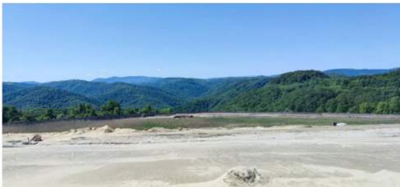
Slika 8.13. – Pogled na betonsku branu sa brane 4, maj 2022. godine
