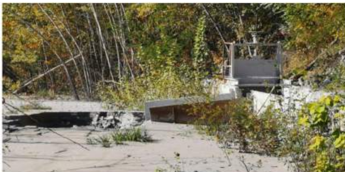
Slika 7.15: Ispust na betonskom kanalu na desnom boku brane "Vančev Potok"
