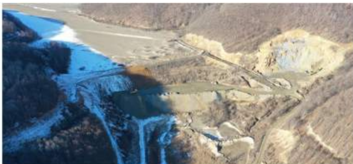
Slika 8.29. – Snimak dronom iz vazduha zemljane brane "Šaški Potok" na kraju izvođenja sanacionih radova, januar 2020. godine
