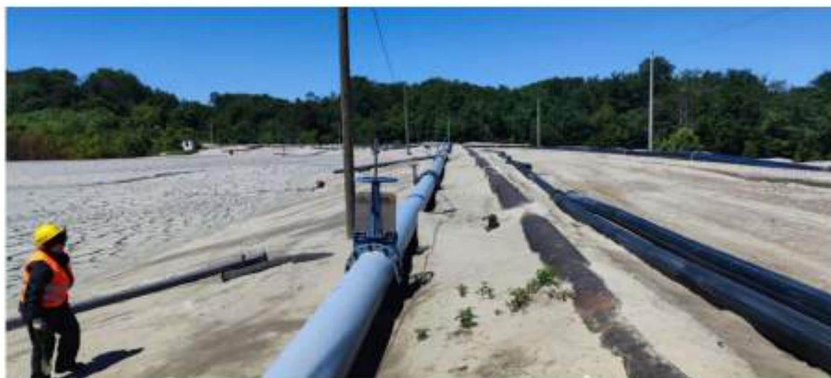
Slika 8.16 - Novi cevovod u operativnom radu na proširivanju plaža ispred brane "Prevoj Šaška", maj 2022. godine
