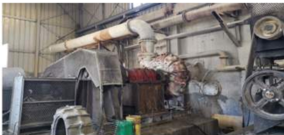
Slika 8.22: Pumpna stanica "Kaluderica"
