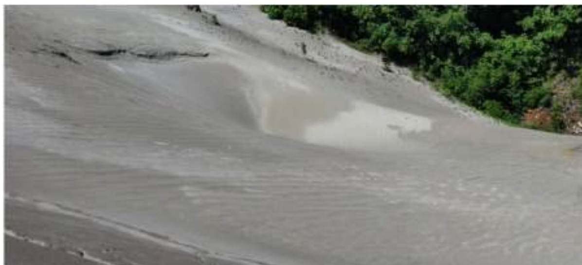
Slika 8.8 – Krater na nasipu br. 6 snimljeno maja 2022. godine
