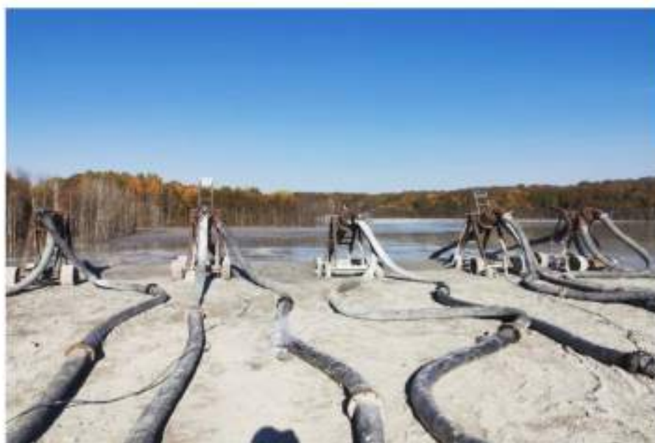
Slika 7.16: Izgradnja nasipa br. 6 u pravcu brane "Vančev potok" pomoću 5 HC postavljenih frontalno, snimljeno 18.10.2019. god.
